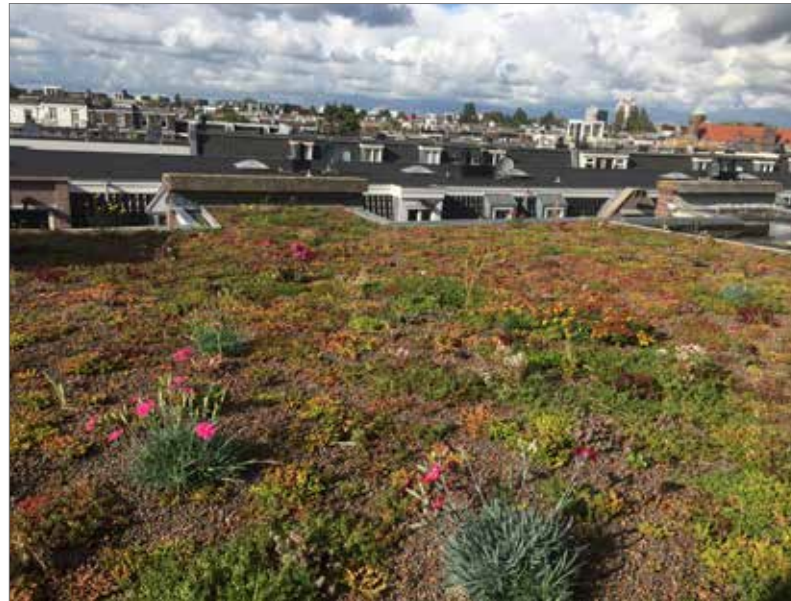
Referentie: Extensief sedumdak Tweede Atjehstraat
