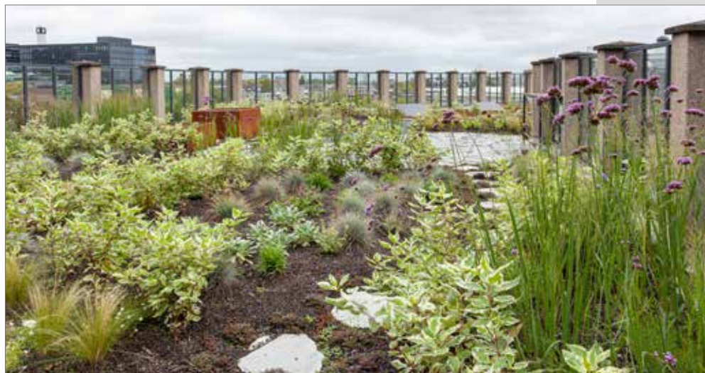
Referentie: Daktuin op kantoorpand Wibautstraat
