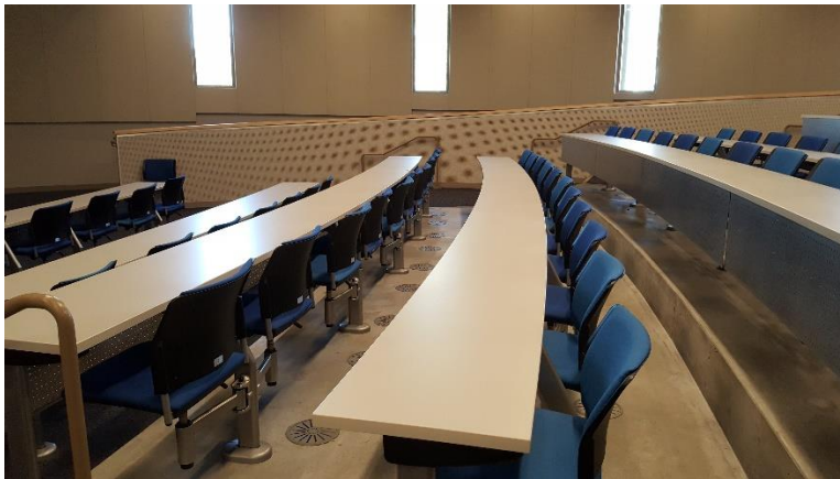
Met een speciale stoel oplossing: 2 stoelen hebben een gezamenlijke poot in de grond, en men kan zo makkelijk omdraaien naar de andere tafel. In tegenstelling tot stoelen op draaiwielen heb je iets minder ruimte nodig tussen de tafelbladen. Foto: Marij Veugelers febr 2019
