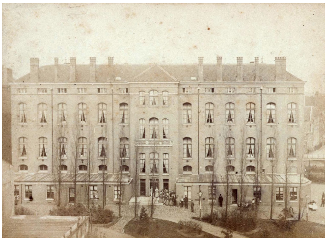
Afb. 151: ca. 1875 BG2 gevel - Hoeveel soberder dan de voorkant, kende de achtergevel van BG2 oorspronkelijk een mooie aanzicht
