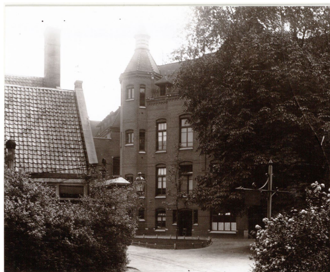
Afb. 171: 1912 De voorgevel v.d. UB was lager t.b.v. overgang naar Regenten huis & tuin
