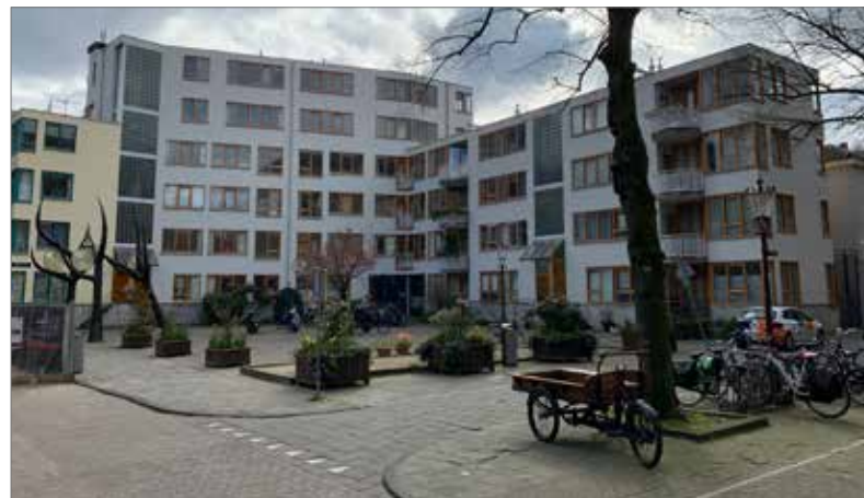
Binnengebied - woningbouwcomplex aan het Binnengasthuisplein
