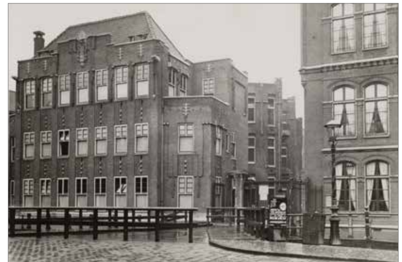
Administratiegebouw BG3 vanaf de Grimburgwal 1887
