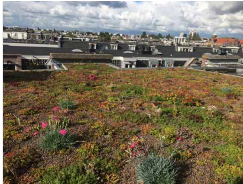
Referentie: Extensief sedumdak Tweede Atjehstraat
