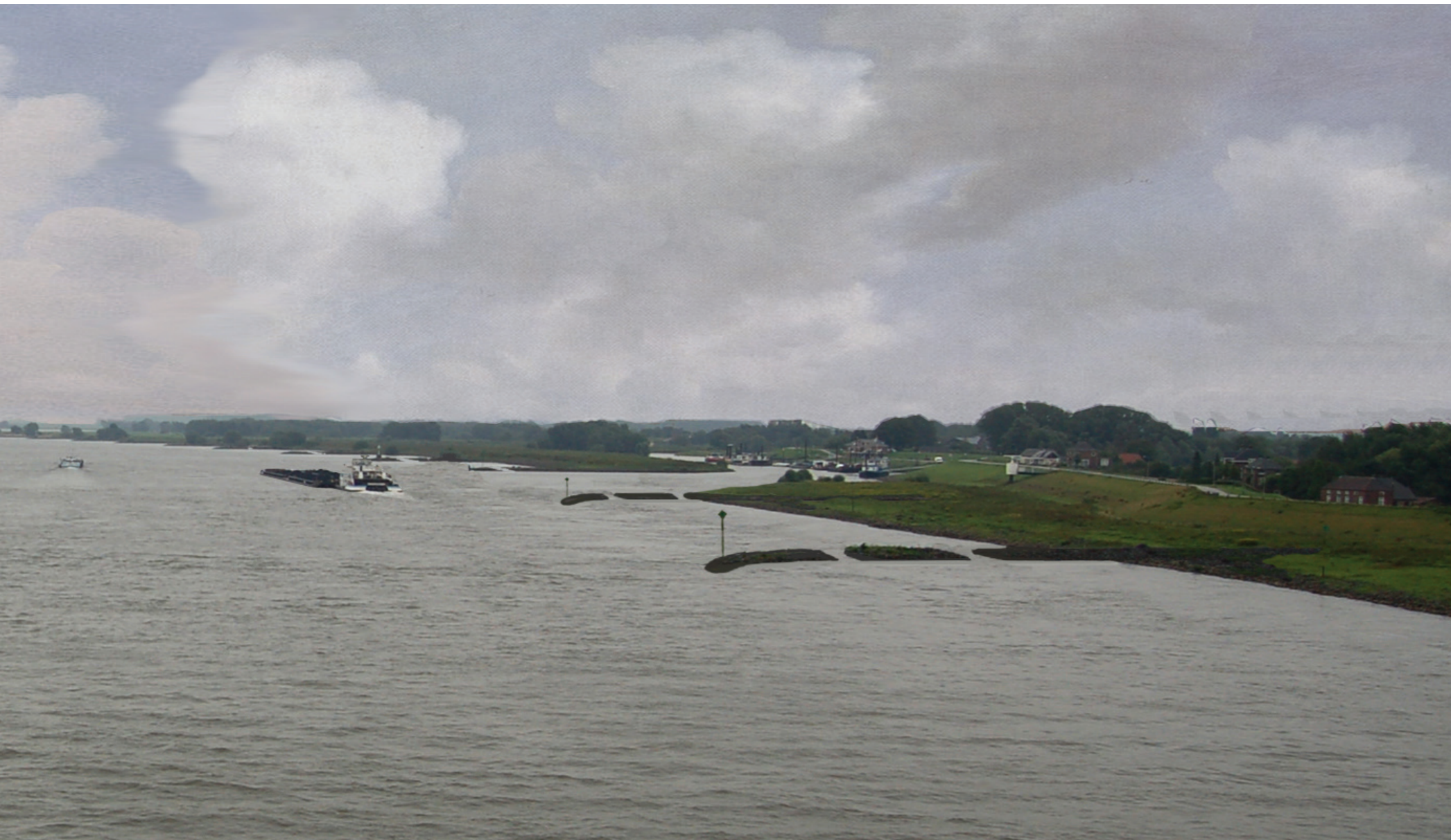
De Waal stroomopwaarts gezien vanuit de stuurhut van een schip. Jack benadrukt de wijdsheid van de rivier. De gelede kriblichamen versterken de visueel ruimtelijk samenhang tussen de kribvakken.
